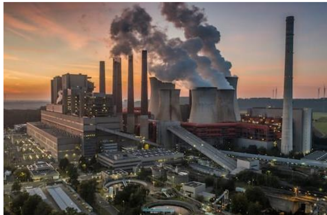
Luftaufnahme des Kohlekraftwerks Neurath in Nordrhein-Westfalen bei Sonnenuntergang (Archivbild). Getty Images/iStockphoto.
